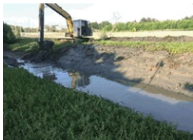
河川の浚渫工事 (SGS)
