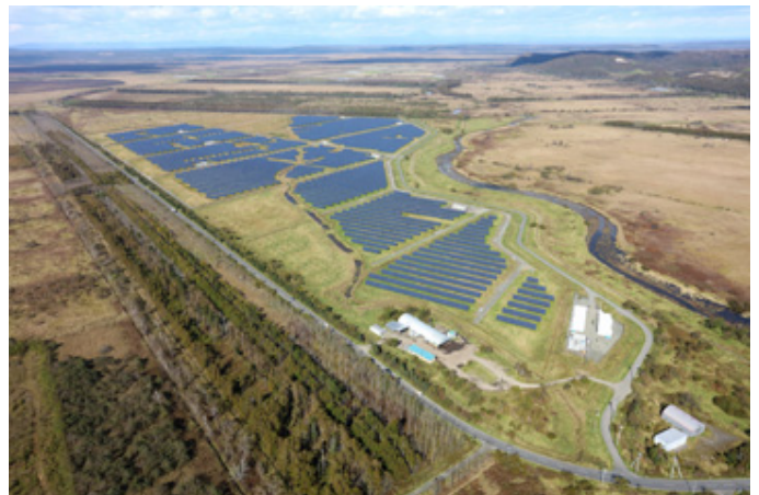
釧路町トリトウシ原野 太陽光発電所全景
