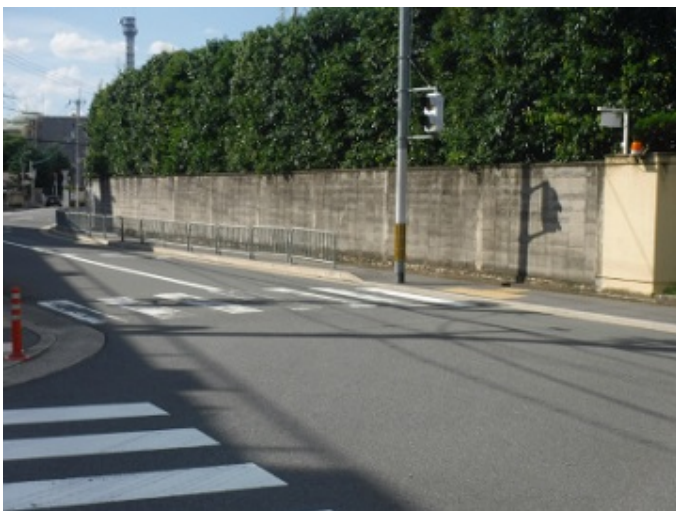
外壁改修工事前
