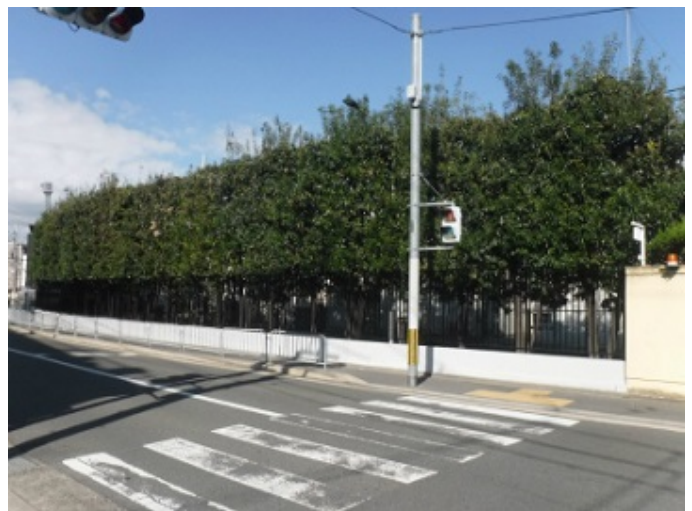
外壁改修工事後
