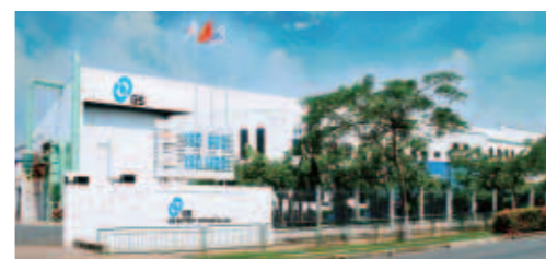
ジーエスバッテリー ベトナム
