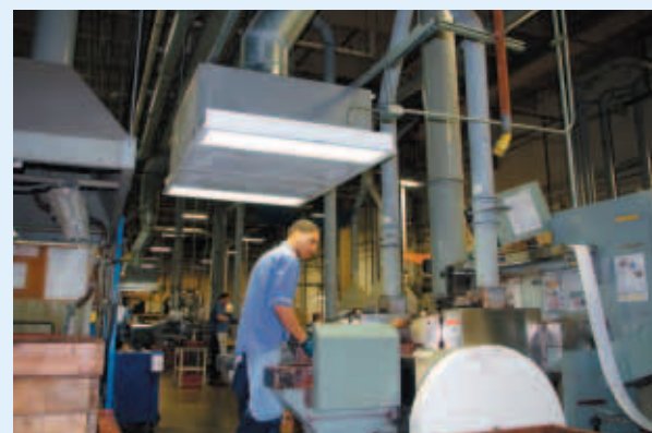
Air shower 风淋装置
