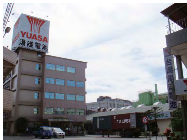
台湾汤浅电池股份有限公司 总社、新庄工厂 Taiwan Yuasa Battery Co., Ltd. Head Office & Hsin Chuang Plant
