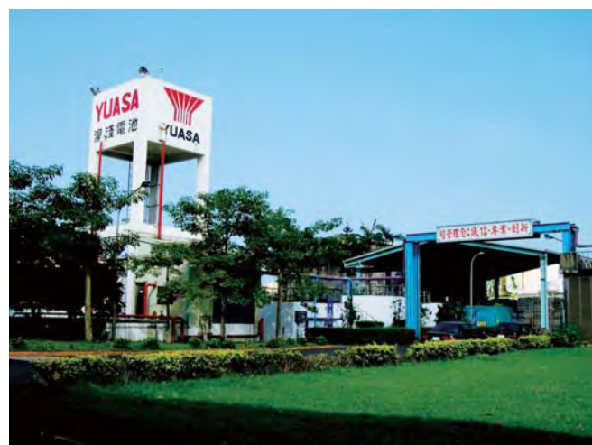
台湾汤浅电池股份有限公司 宜兰工厂 Taiwan Yuasa Battery Co., Ltd. I-Lan Plant
